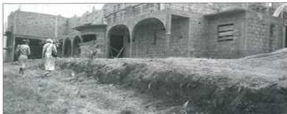
La Maison du diabète à Etouffé en cours de construction.
