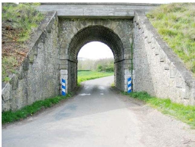
Pont de chemin de fer, de la ligne Chartres-Maintenon, construction en moellons de silex, pierre de taille de grès
